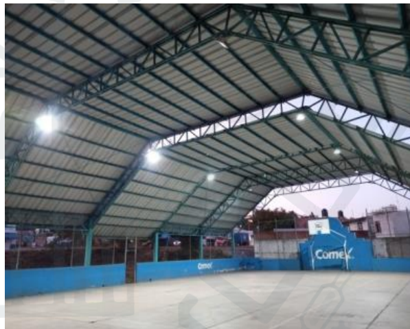
Cambio de luminarias en Canchas de Usos Múltiples.
