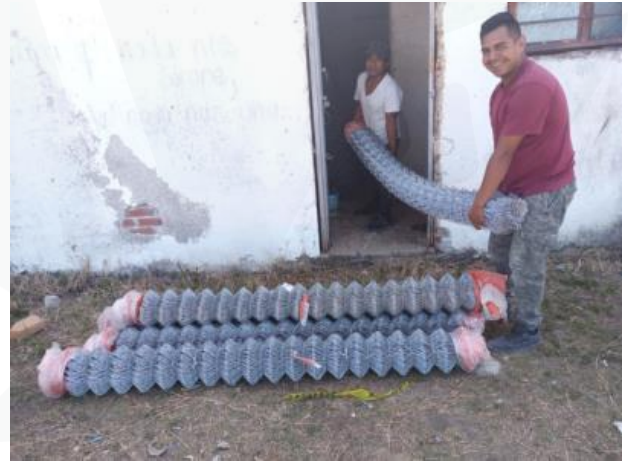
Trabajos de mantenimiento del Campo N°1 de Fútbol de la Unidad Deportiva.
