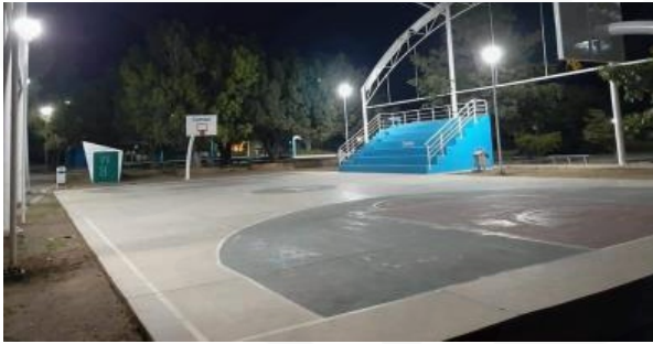
Reinstalación de luminarias en Unidad Deportiva.
